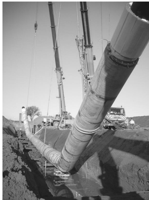
Fig. 4.21 Siphon préfabriqué amené dans le conduit de siphon puis poussé dans le lit de la rivière sur des rouleaux [51].
