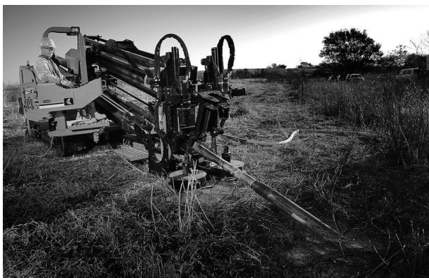
Fig. 4.20 Utilisation d'une machine de forage dirigé.
